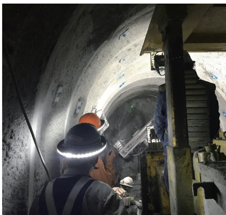
トンネル工事での使用例
