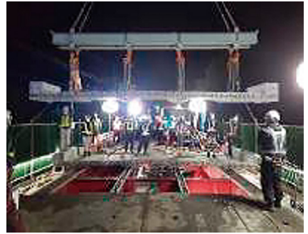
施工例：第一次緊急輸送路
