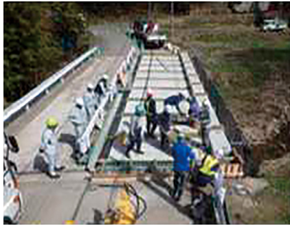
施工例：片側交互通行
