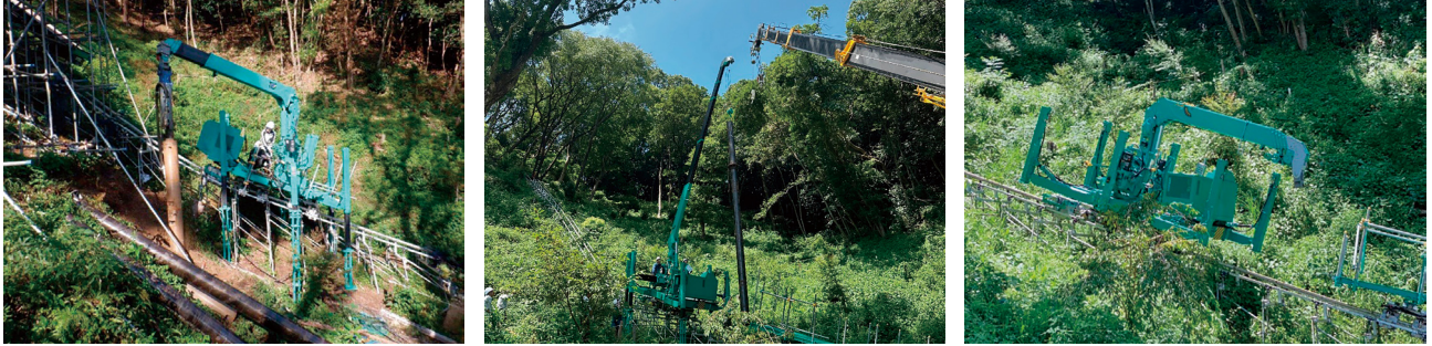
モノレールクレーンを活用したTP工法
