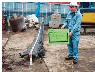
撤去された地下躯体
