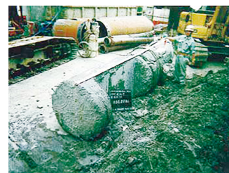
撤去されたシートパイル
