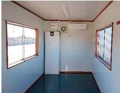
太陽光発電設備と蓄電設備を積載した独立電源型ユニットハウス
