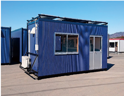
太陽光発電設備と蓄電設備を積載した独立電源型ユニットハウス
