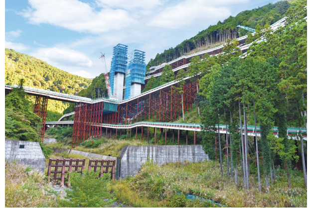
工事用道路 施工例
