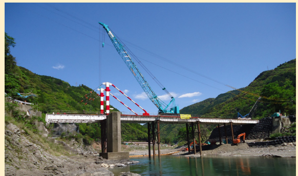
20m支間施工 L栈橋
