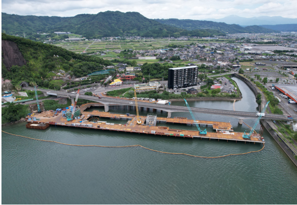
作業構台 施工例
