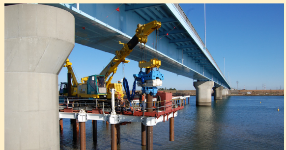
低空頭施工 フェニックス・ステージ工法
