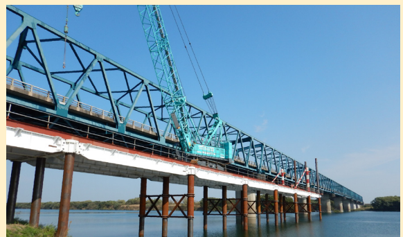
12.5m支間施工 LIBRA II
