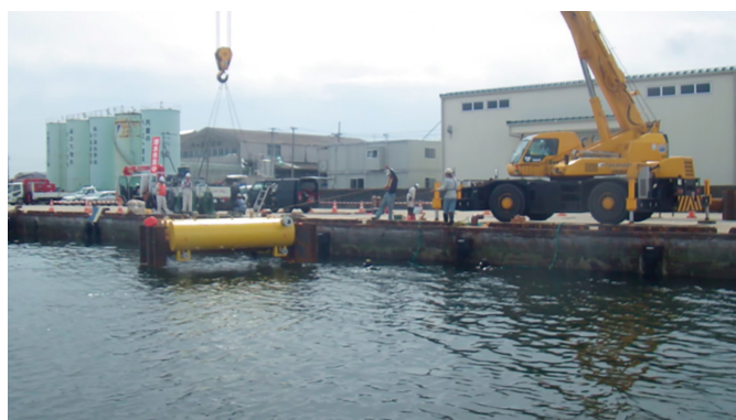
専用のフローターを使用した施工状況
