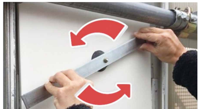
取り付け・取り外し方法は上下2カ所のレバーを回す
