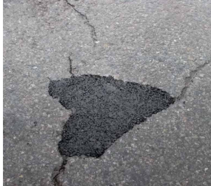
ポットホール補修に
