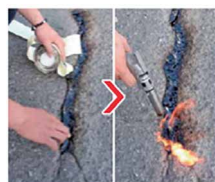
舗装クラック補修
