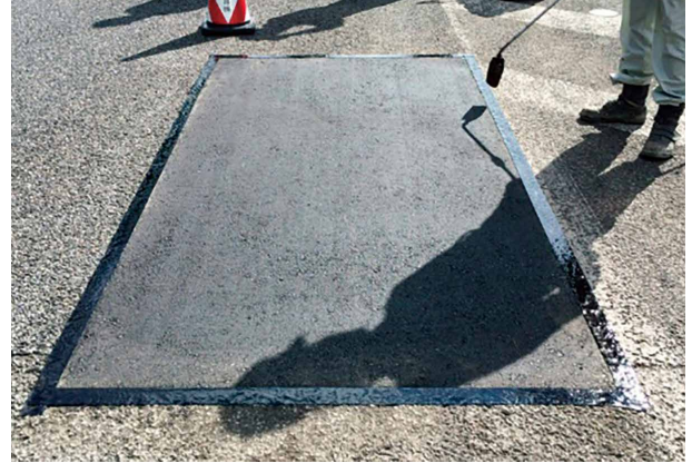
施工事例 (シールコート)
