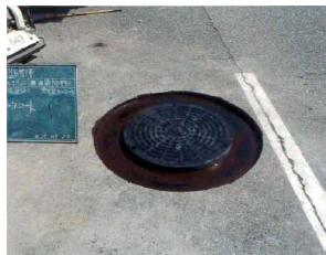
SSコンクリート硬化後、 乳剤塗布
