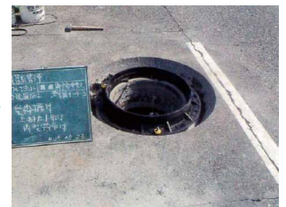
調整ナットを回転させて レベル調整
