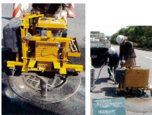
サークルカッター 設置
