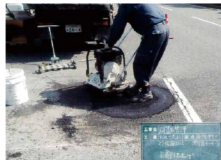
再生密粒度アスコンを使用して 締め固めて仕上げ (仕上げ材は選択可能)
