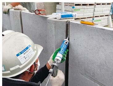
⑤縦目地にシーラー塗布 その後シリコンコーキング材で縦目地打ち
