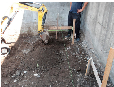
①柱基礎用の堀削作業
