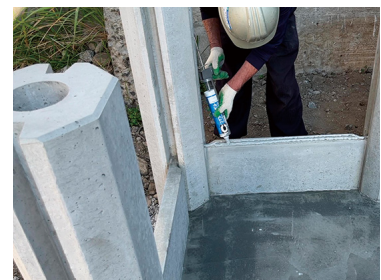
③耐圧板設置（1段目） 板上部にシリコンコーキングを充填
