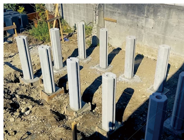
②柱の建て込み 根固めコンクリート打設
