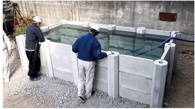
高さ1.1mの止水堀
