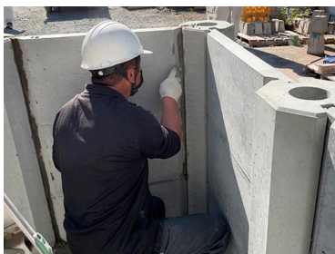
④2(3)段目の耐圧板を重ねる モルタルで縦目地打ち
