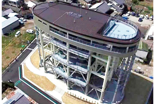
設置事例 (高知県黒潮町)
