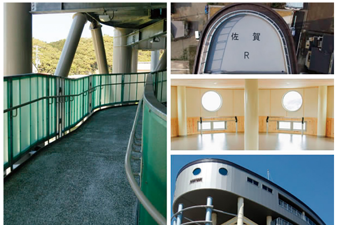
車椅子用スロープ、ヘリからの救援スペースも備えた国内最大級の津波避難タワー(2017年高知県黒潮町)
