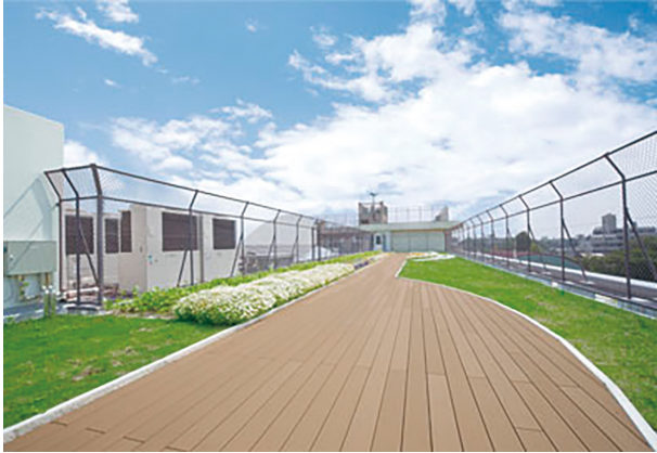
デッキ施工例
