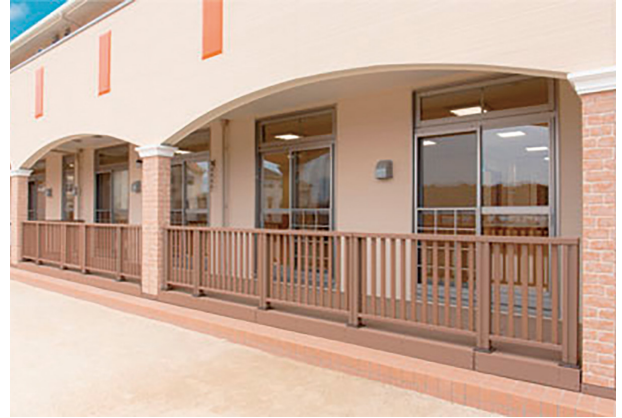
フェンス施工例
