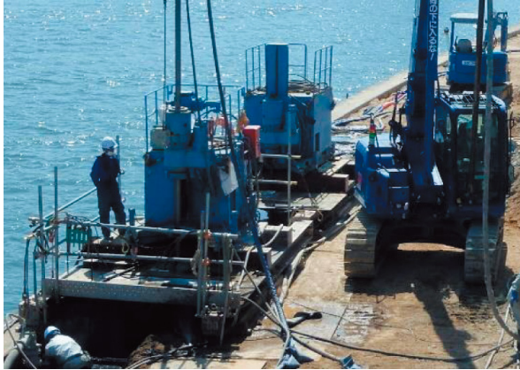
PJG工法 施工状況
