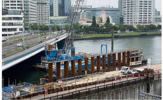
栈橋支持杭の構築（長尺杭・高天端・飛び杭）
